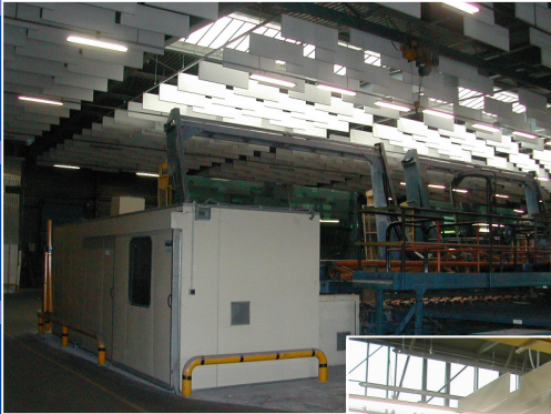
Correction par baffles d'un bâtiment
