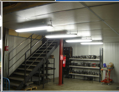
Correction plafond et murale
